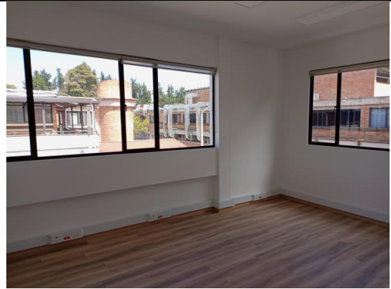
OFICINAS DE QUIMICA: Piso SPC, divisiones y ventanería en vidrio/aluminio, pintura en vinilo.
