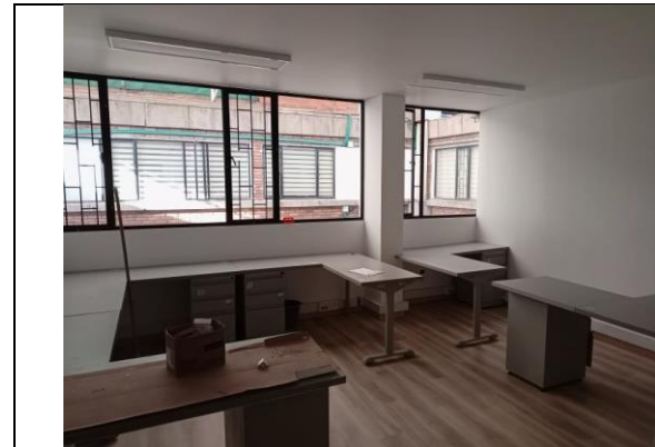
OFICINAS DE VIGILANCIA: Piso SPC, ventanería en aluminio, pintura en vinilo, luminarias.
